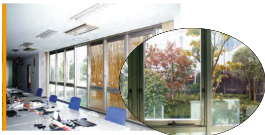
■ 完了 正面撮影にて歪みの確認（約3M） ・・・ほとんど無し
