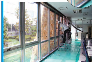
■ サーモバリアコーティング作業（ローラー塗布）
