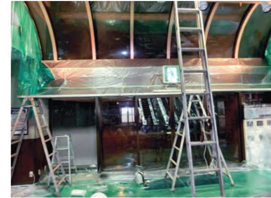
■施工前養生/足場布設
