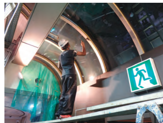
■サーモバリア塗布（ローラー塗り）
