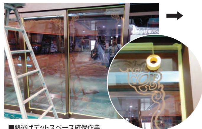
■熱逃げデットスペース確保作業 《3~5mm程確保》
