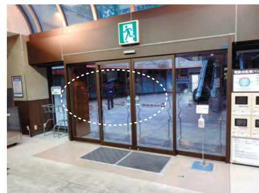
■完了/午前5時撮影 透明度は変化無し（自動ドア）
