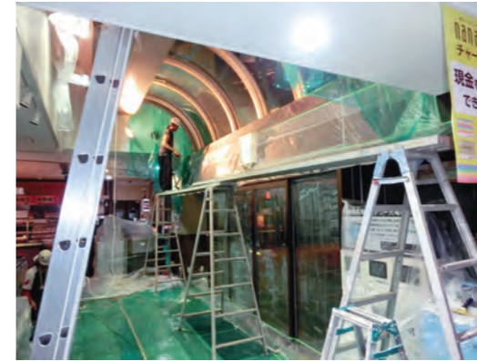
■施工前養生/足場布設
