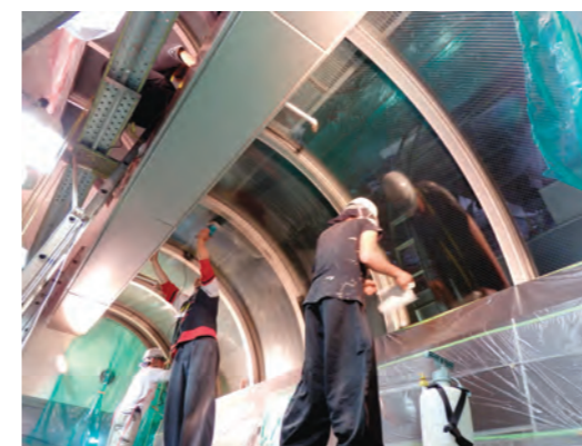
■ガラス研磨剤にて、汚れ・油膜等の除去作業 ※【表面の親水性態確保作業】
