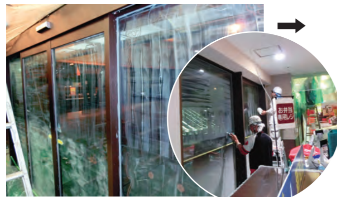
■ガラス研磨剤にて、汚れ・油膜等の除去作業
